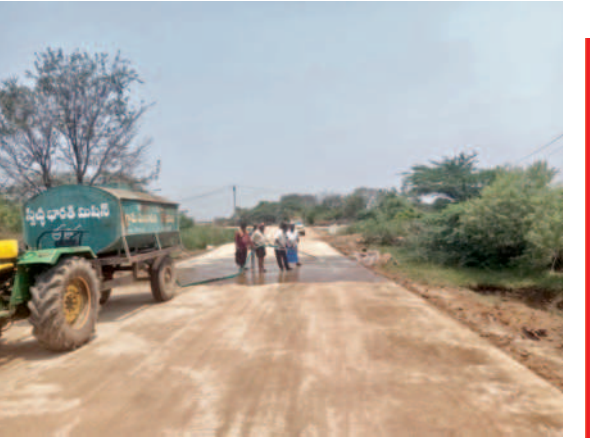
నిర్మాణం పూర్తి అయిన సిమెంట్ రోడ్డు
